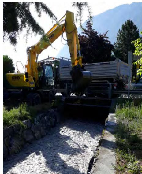
// De gauche à droite: Crue du 2-3 juillet 2019, niveau alarmant de la Sinièse / Dépotoir amont de la Loquette, rehaussement des murs et approfondissement de l'échancrure / Crue du 2-3 juillet 2019, curage au niveau du pont de la route du Simplon.
