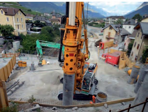
L'impressionnante foreuse qui a servi à forer les premiers pieux du tunnel. Une machine flambant neuve de 90 tonnes.
