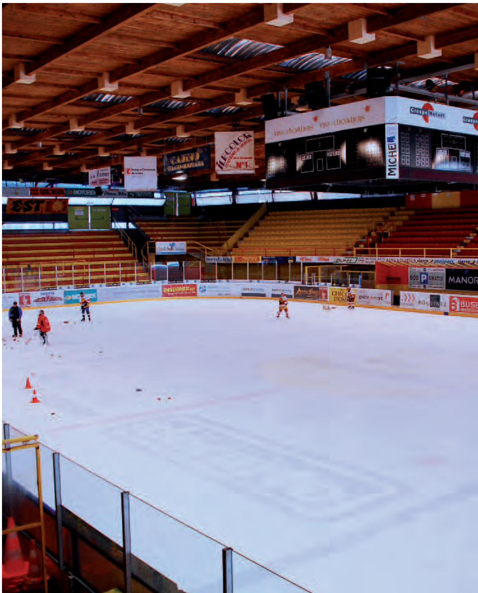
Vétuste et située sur le futur tracé de la route entre la Scie et le rond-point Paradis, la patinoire de Graben sera détruite et remplacée par une nouvelle halle.
