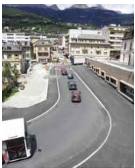
La nouvelle rue libère la future zone piétonne de l'avenue de la Gare.
