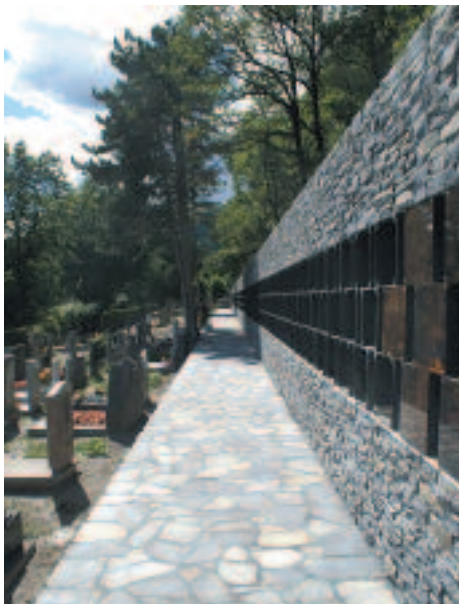
Photo: actes architectes
