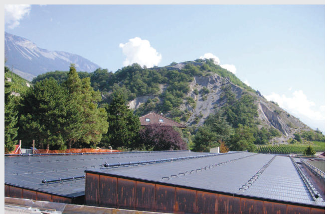
Les nouveaux panneaux solaires thermiques de la piscine de Guillamo
