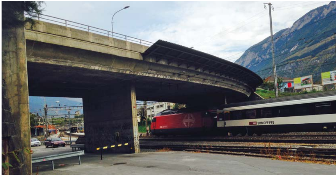
Le pont actuel devrait être démolé et reconstruit dans le courant de l'année 2017.
