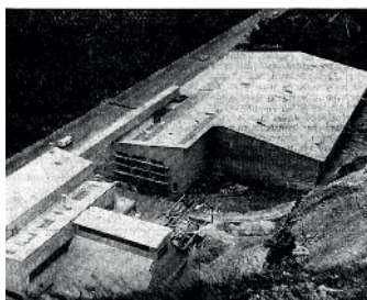
// « Une vue de la nouvelle usine La Plâtrière SA » – 1963.
